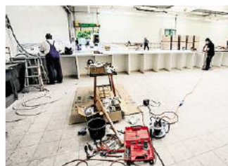
Handwerker bauen die Essensausgabe im Speiseraum zusammen.
